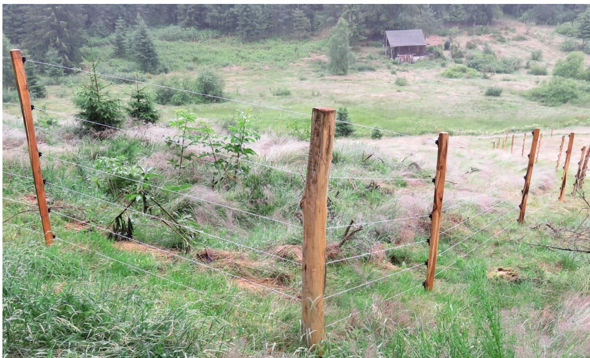
Neuerstellter wolfsabweisender Festzaun mit sechs Litzen im Harzloch bei St. Georgen. Quelle: LEV
